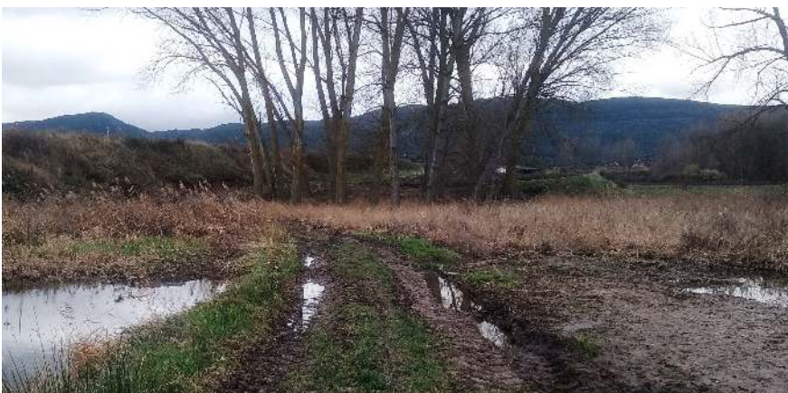
Camino del Azafranal. Ya cerca de la C/ Panamá. El firme se va degradando al alejarse de la ciudad. En el punto más problemático, el encharcamiento lo hace intransitable.
