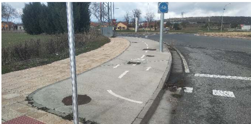
Rotonda Ctra Logroño / Avda Brasil. Punto de cruce de la acera-bici actual con la calzada.
