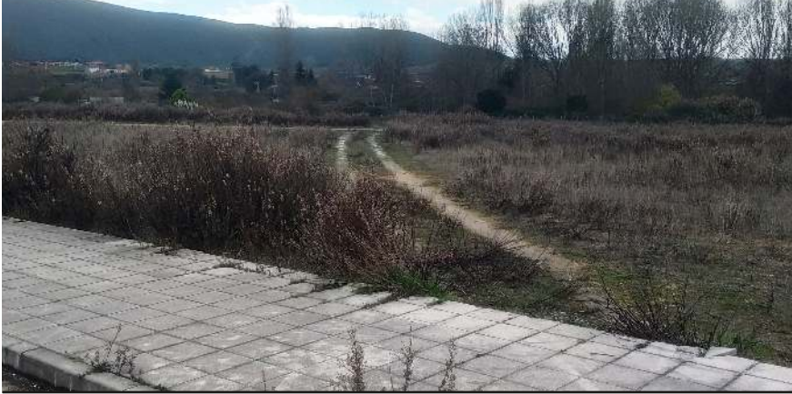
Calle de Panamá. Una de las posibles conexiones entre el camino viniendo de la ciudad y la red asfaltada. Degradado por la falta de mantenimiento.
