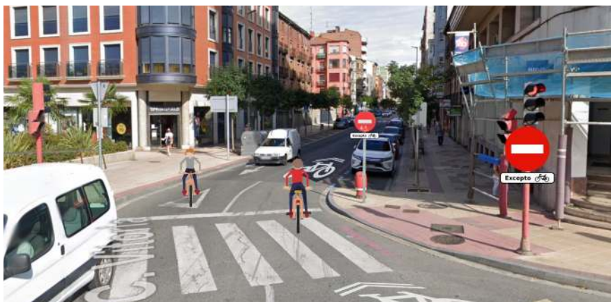
Calle Vitoria. Adaptación mínima suficiente (señal vertical, marca vial) de la entrada al sentido reservado a bicis, desde la M.
