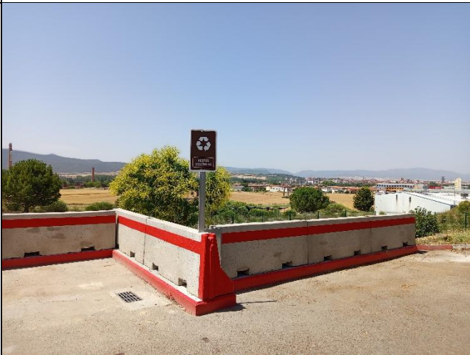
Nuevas barreras en muelles con señalización
